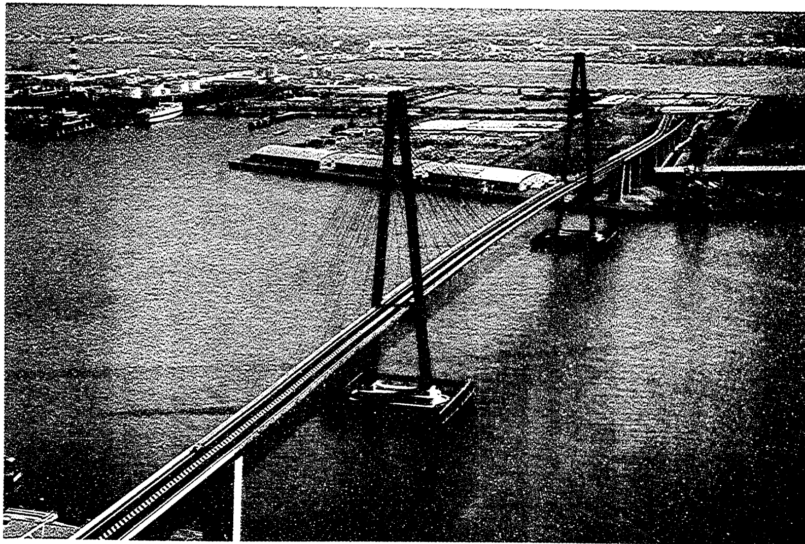
写真-2.4 名港西大橋全景（その2）
