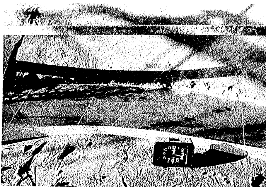
写真－2.9 溪岸侵食状況（モルタル面が露出）（CASE 1 15分）
