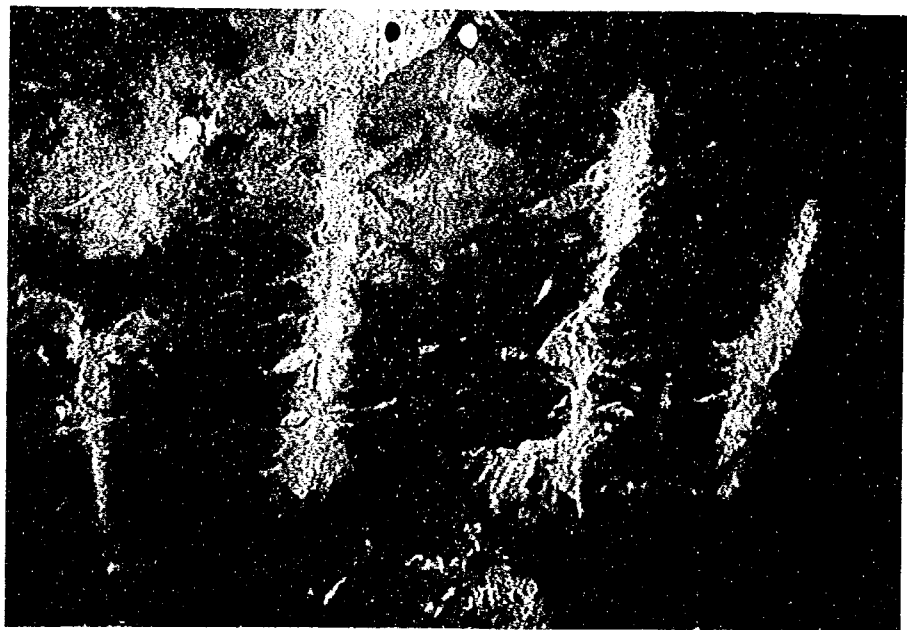
写真-3・4 ケース2 右天端部ノミ跡状況 (白く写っているのが、装薬孔におけるノミ跡であり、それらの中間のノミ跡は空孔である。)
