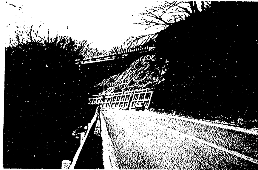
補強箇所全景
