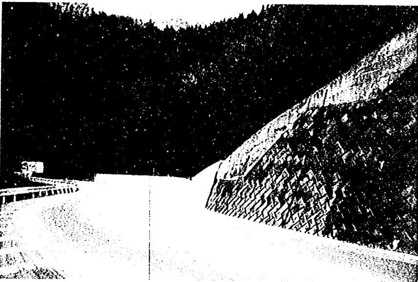
補強箇所全景
