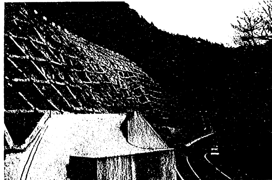
場所打ち枠工とアンカー工を主体にした補強後の斜面状況
