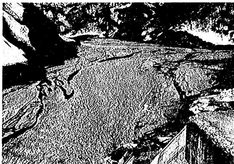
写真- 3.3 砂防ダム上流堆砂地の侵食状況
