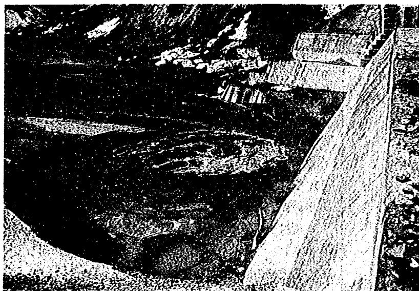
写真- 3.2 砂防ダム上流の吸出し状況
