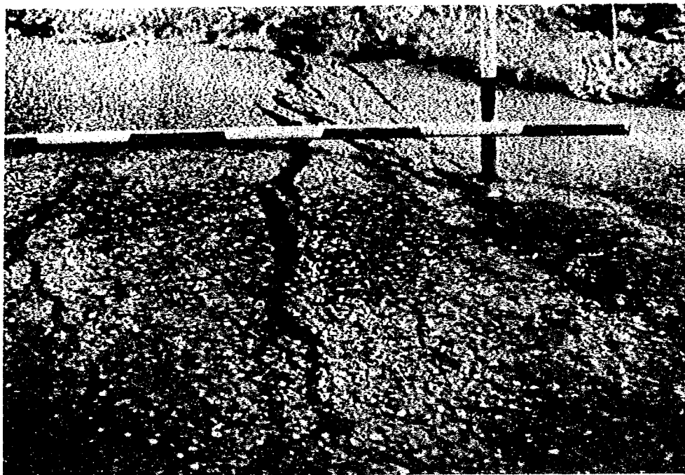
写真-5 地すべり側面部が西側に広がる部分の 道路被災状況
