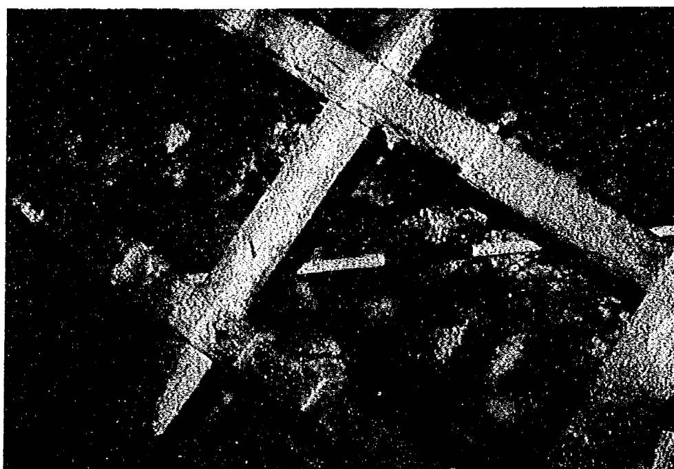
写真-10 末端部の家屋土間に生じた圧縮キレツ
