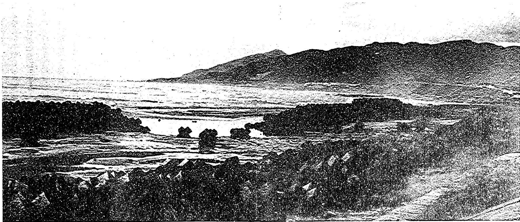
写真—4.3 第1波津波来襲直後の状況（八森海岸）
