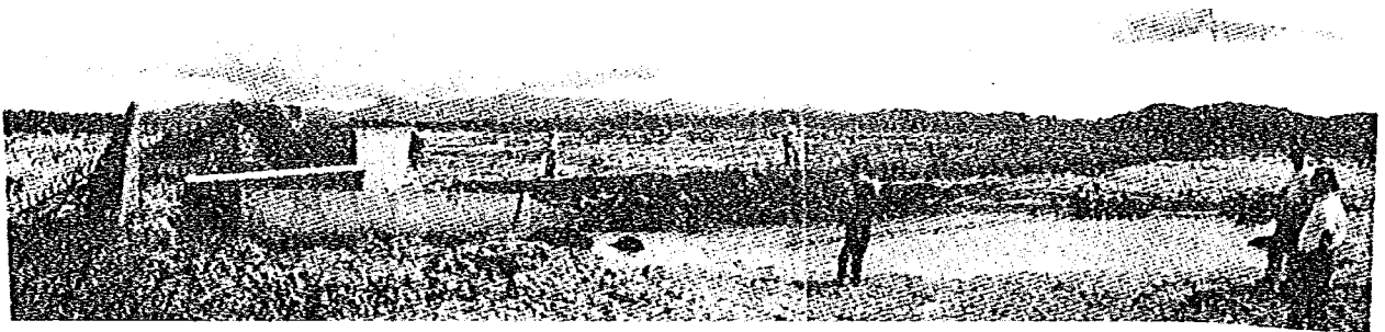
写真—4.9 竹生川，河川堤防背後の洗掘穴
