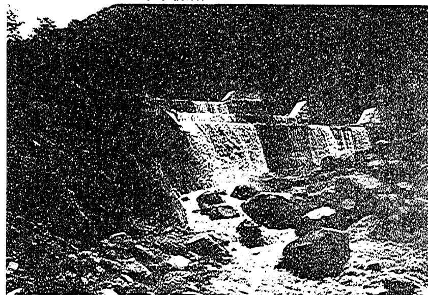
写真-12 細谷第3号砂防ダム副ダム下流洗掘状況 (金沢工事事務所)
