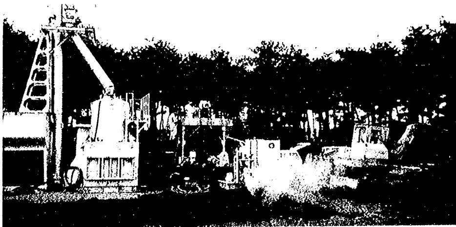
写真－4.4 2号機による土質改良実験
