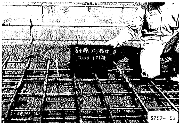
写真－2.5 床版コンクリート打設
