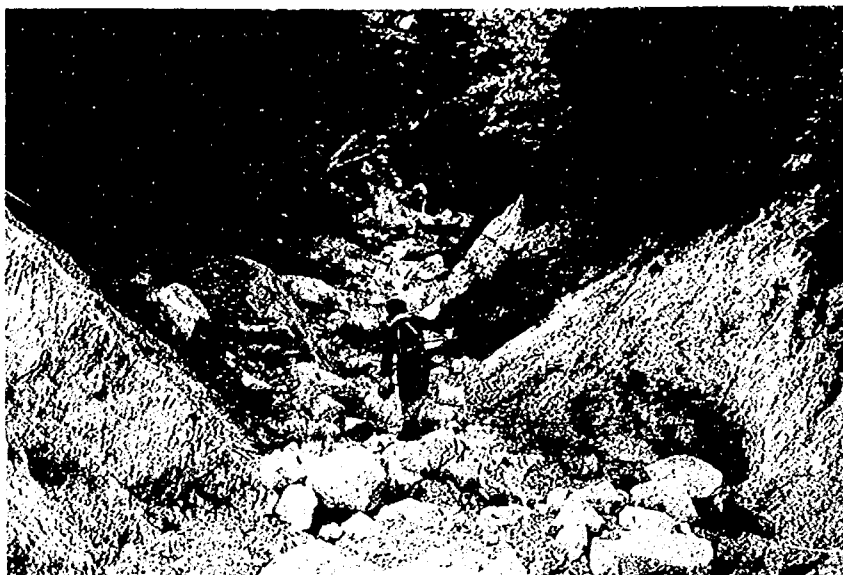
写真-7 落合川空沢 (多治見工事事務所)
