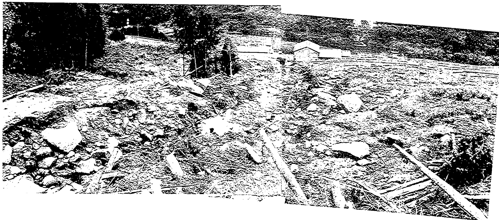
写真-2.7 水谷川堆積部
