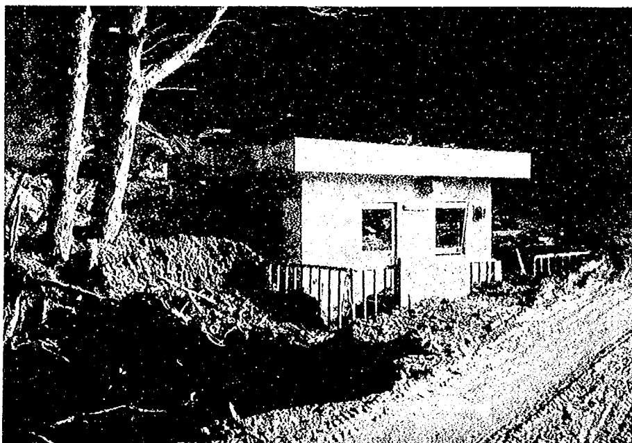
写真一 4.18 半ば埋没した鍋倉簡易水道建物。立木の向って左側が埋塞された河道と道路をくぐるカルバート。向って右側は元畑地。建物の背後がダム工事個所。㊧
