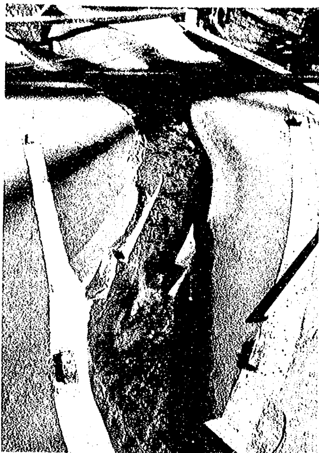
写真－3 減水期の流路工内の土砂堆積状況（タイプ3）
