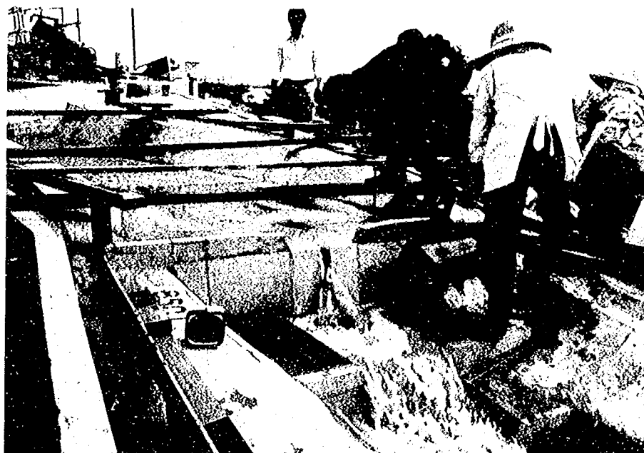
写真-7 ダム軸変更前の日影第1号砂防ダム前庭部の流況 (流量 181 \text{ m}^3/\text{sec} )
