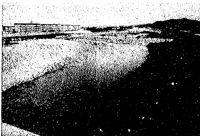
写真－8 新松川橋の下流の河道状況 (61年11月撮影、61年8月の出 水後の状況)
