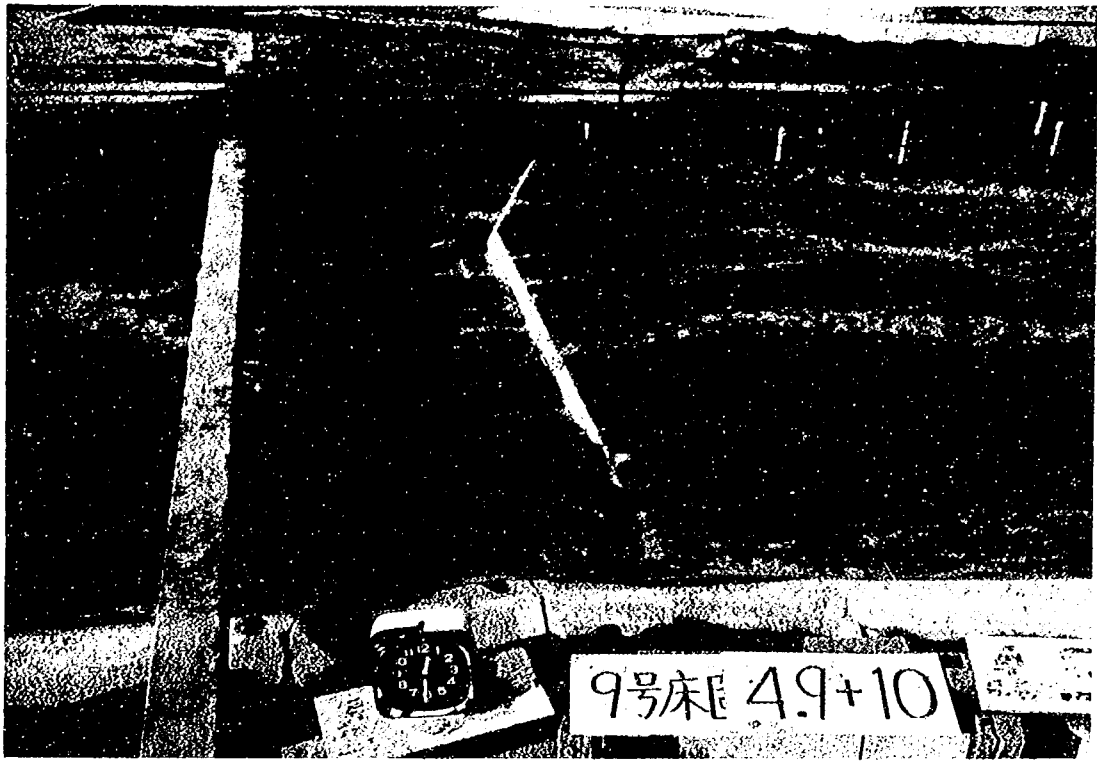
写真-1.9 9号床固下流の洗掘（一時的）
