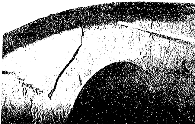
写真-2 躯体部壁立上ハツ部のき裂
