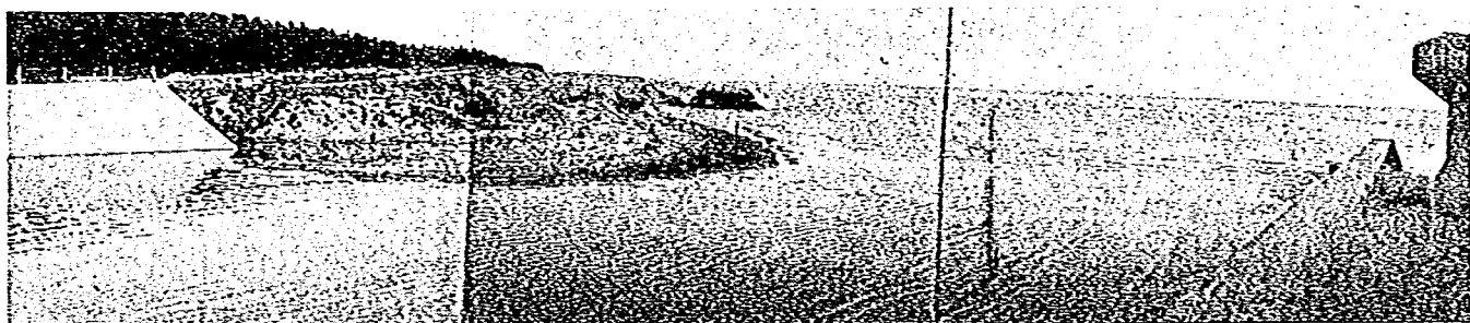
写真-16 黒瀬川 (河口左岸側に砂州が形成され、右岸側壁内が暗きよと なっている。1977年8月26日)
