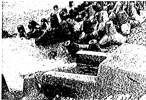
写真-18 上原用水（吐口は暗きよとなっているが、敷高は比較的高い。1977年8月25日）
