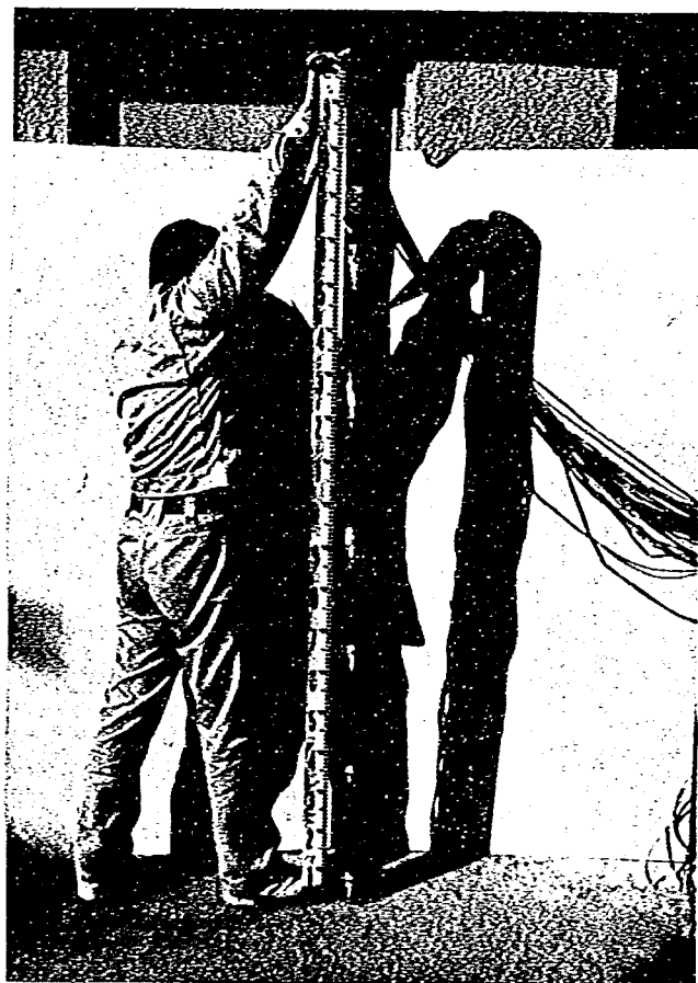
写真4 加工された鋼管杭 （所定の位置に圧力センサーを設置）
