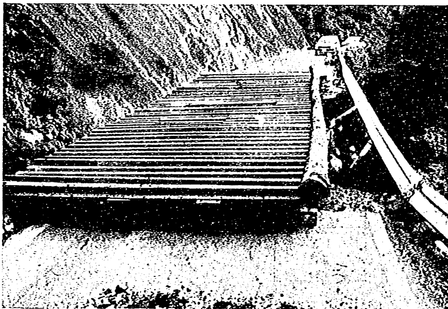
写真4.4.15 応急復旧で用いられた仮橋の施工状況(越木曾福島線 西野川下地区)
