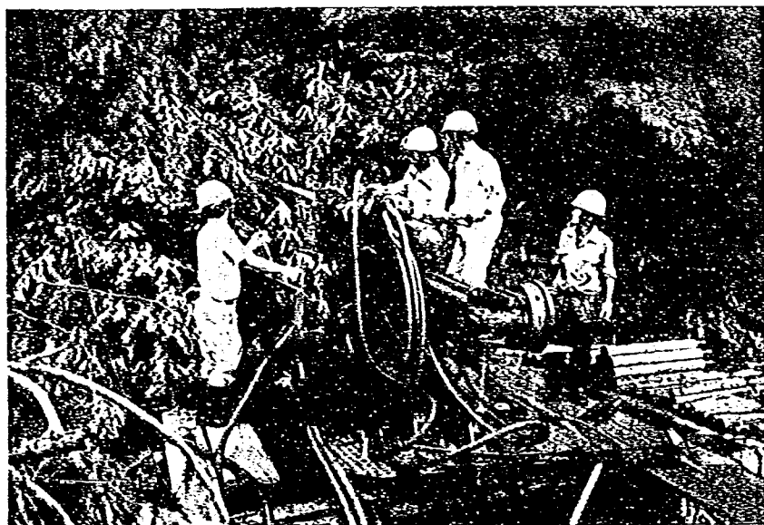
写真-6 Iブロック末端部における集水ボーリング工
