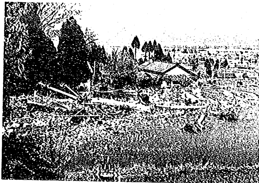
写真一 1 流路に設置された小橋梁（左手中央，長さ約2 m）に流木が詰まって氾濫した土石流と流木（熊本県高森町，白川左支川冬野川，昭和63年5月 熊本県撮影）
