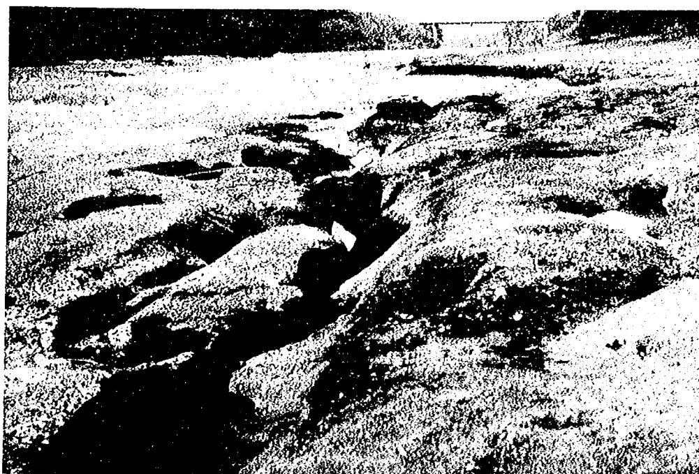
写真1 荒川58.5 km地点、洪積層の露出状況
