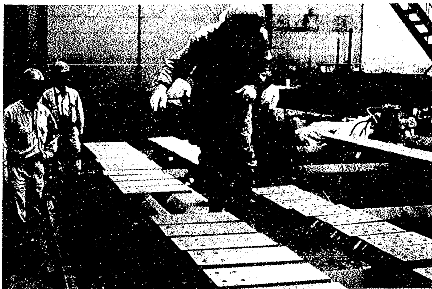
写真-1 塗装作業
