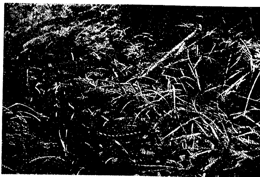
— 植栽施設の状況（トリカルネットの劣化，表土若干流出）—
