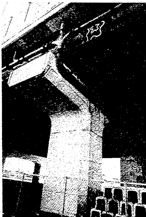
主桁座屈及び橋脚 P 10 クラック
