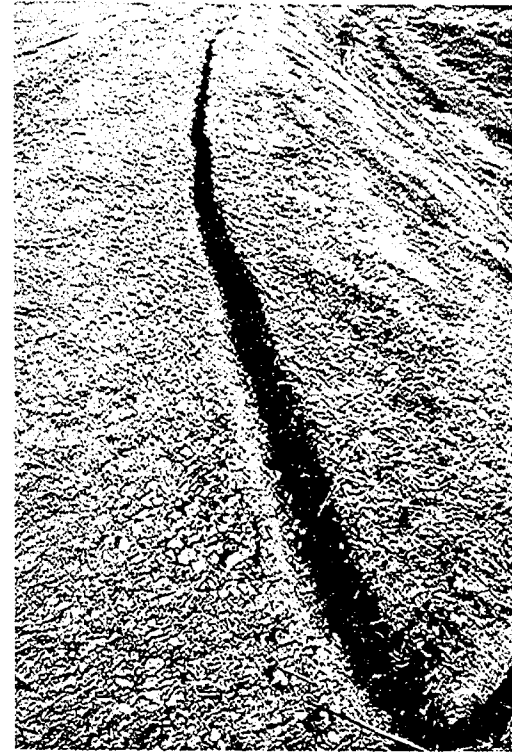
堤体クラック
