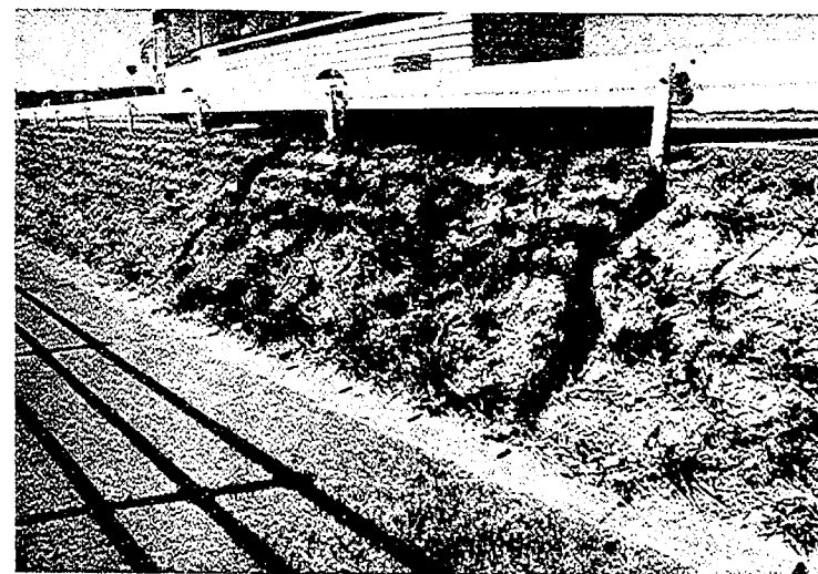
盛土クラック
