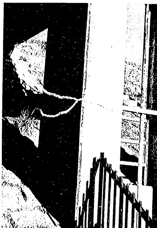
門柱クラック
