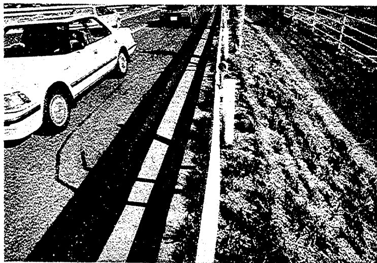
路面クラック
