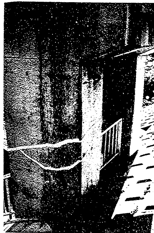
門柱クラック
