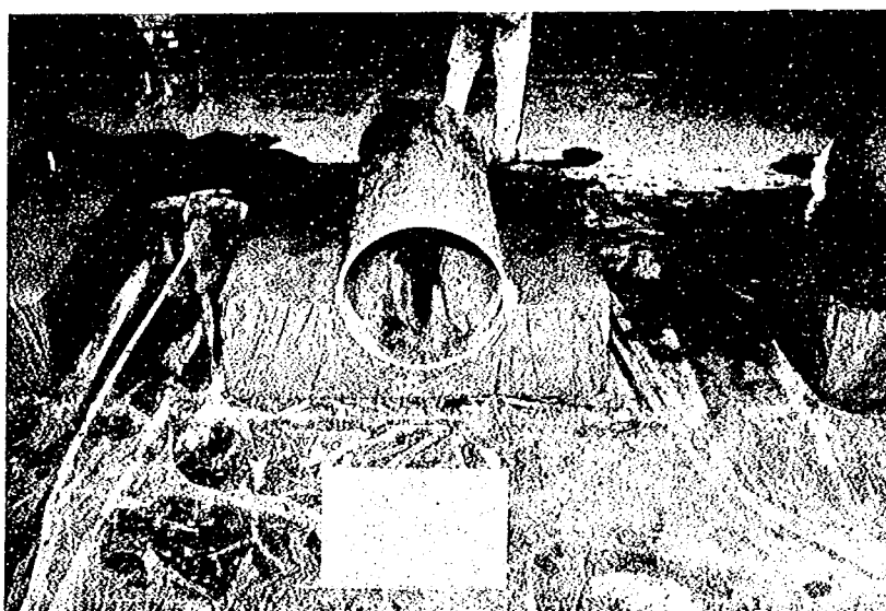
型枠取り除き後 (材令3日)
