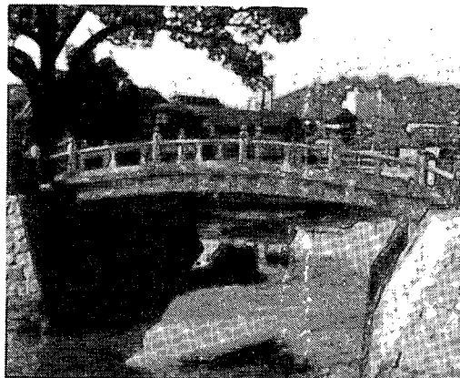
b) 改修後の橋梁と護岸
