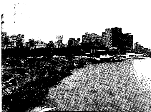
(a) 改修前の状況 (北村真一撮影)
