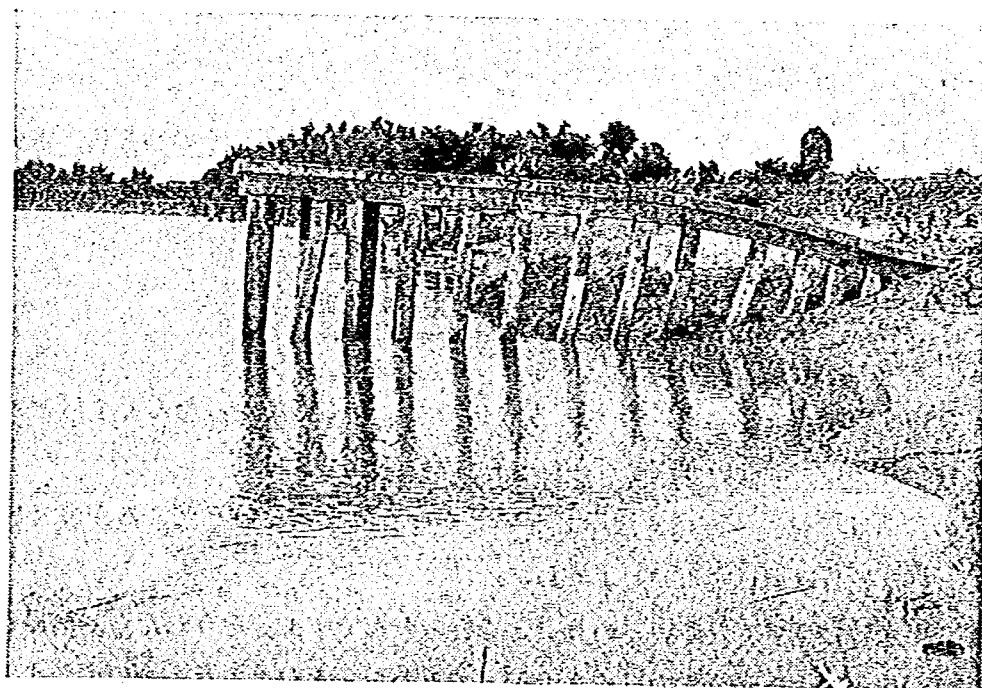
写真3-6 コンクリート透過水制 (写真提供 田代順一)
