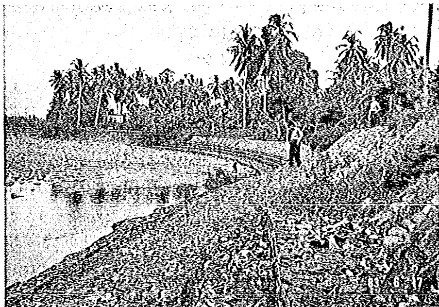
写真6-10 バダンのアイルディンギン川の蛇かご護岸 (写真提供 日本建設コンサルタント)
