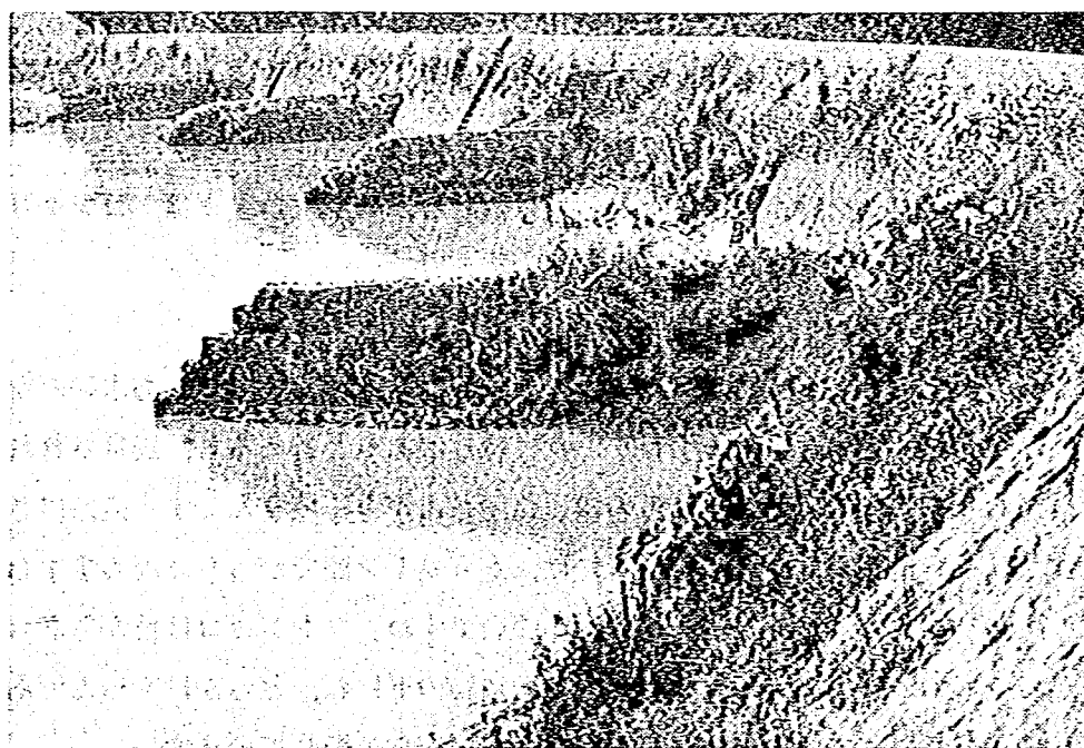
写真6-11 ふとんかごによる水制 (写真提供 田代順一)
