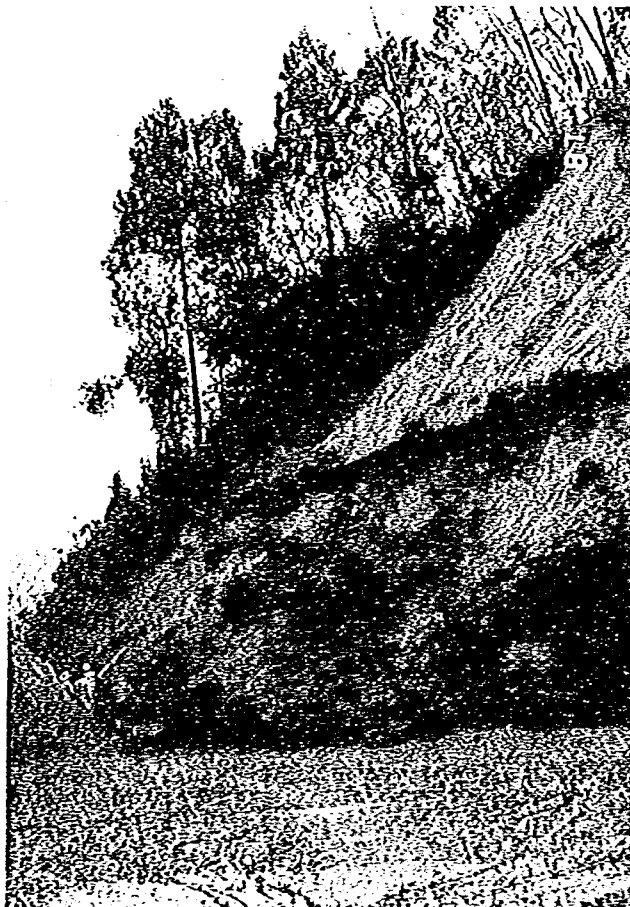
I-4 市原市上畑の崩壊斜面 切り通しとなっている斜面の上部 が崩壊し、道路を埋積した。
