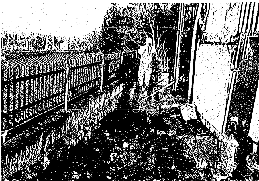
I-1 市原市砂子盛土斜面の上部で沈下
