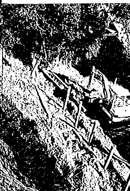
N-3 人家裏急崖の崩壊，白々とした部分が今回の崩壊地。崩壊深は0.5 m以下。斜面中段以下は旧崩壊による崖錐。
