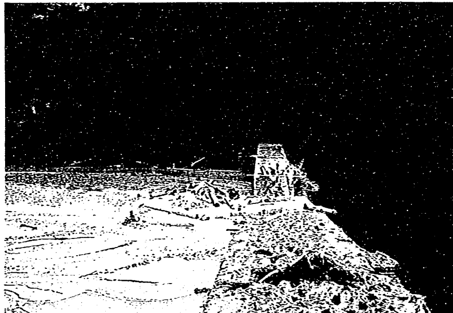
写真-2.3 伊香川砂防ダム袖天端に残る土砂と流木
