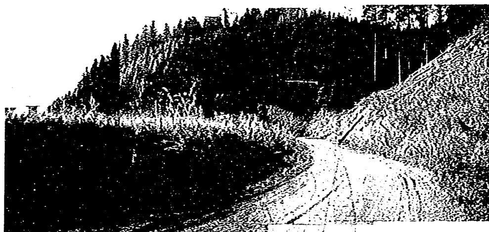
写真－3.3 崩壊地上部にある林道、写真左側に林道建設時の土砂を盛土している。排水施設はなく、雨水は斜面地盤内に浸透しやすい状態にある。
