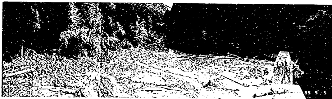
写真-3.8 伊香川砂防ダムの堆砂状況。災害前未満砂であったが、今回の土石流で満砂した。大半の土砂がこの砂防ダムで捕捉された。
