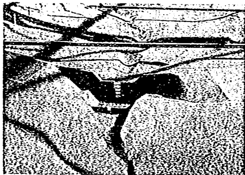
写真-3.18 スリット部：スクリーン間隔 2.0 \text{ m} ( \phi - 0.5 \text{ m} ) 副ダム：水通し幅 20.0 \text{ m} スリット幅 2.0 \text{ m} スリット高 2.0 \text{ m}
