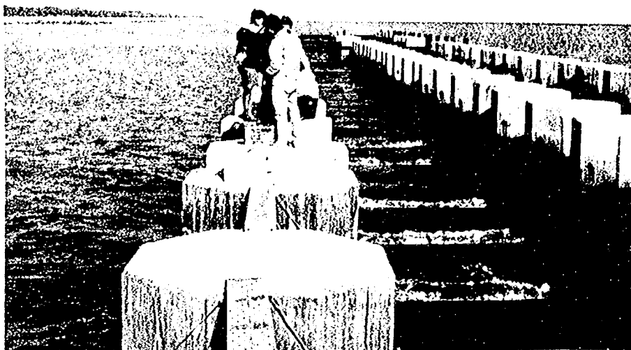
新型離岸堤の付着調査
