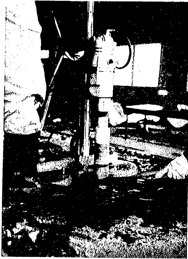
写真-1.3 コンクリートのコア抜き状況
