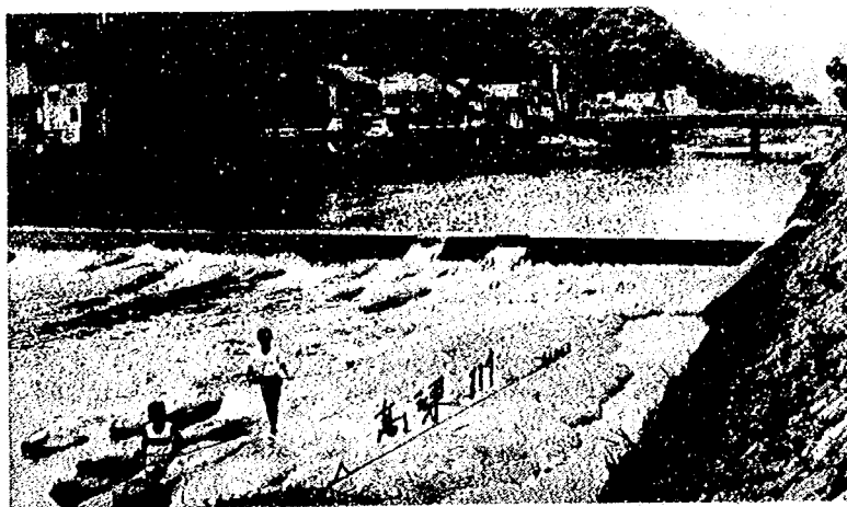
写真－4.19 切り込みを入れた落差工
