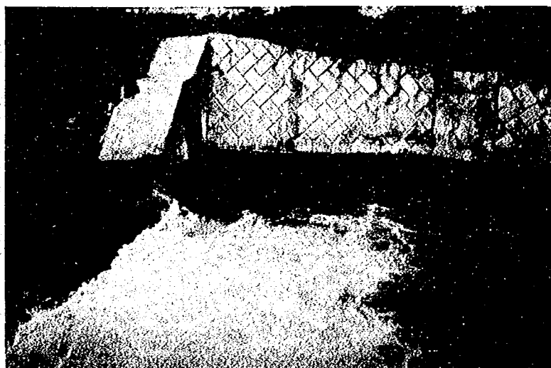
写真－5.3 落差工の落ち込みがS型の淵の役割を果たすことと、護岸の魚巣ブロックによりウナギ、ヤマメなど魚種が多い。（農具川）
