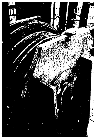
取水設備のシープ
