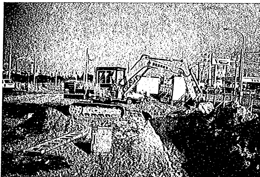
写真-24 発生土による埋戻し状況
