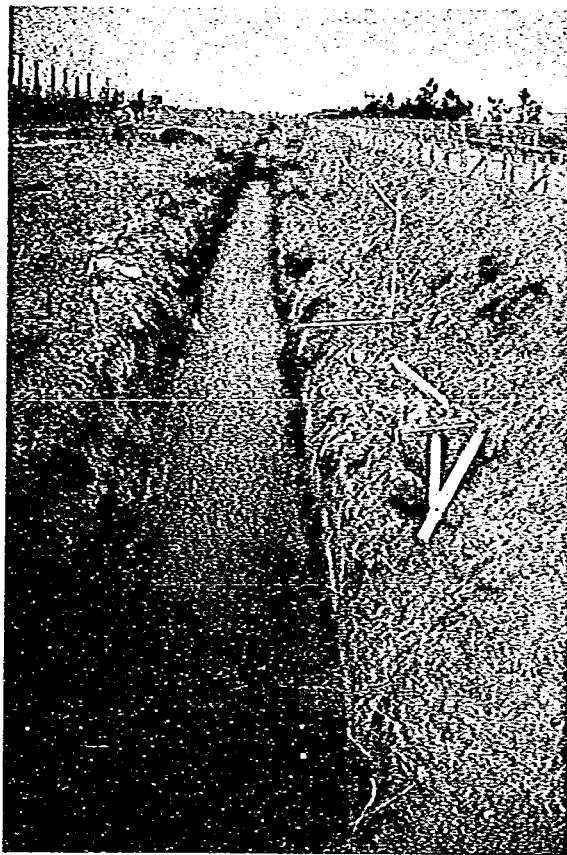
写真-23 山砂による埋戻し状況
