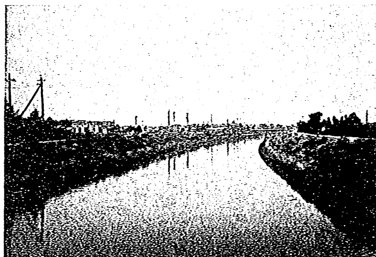
〈写真-3〉 放水路建設予定地である。
