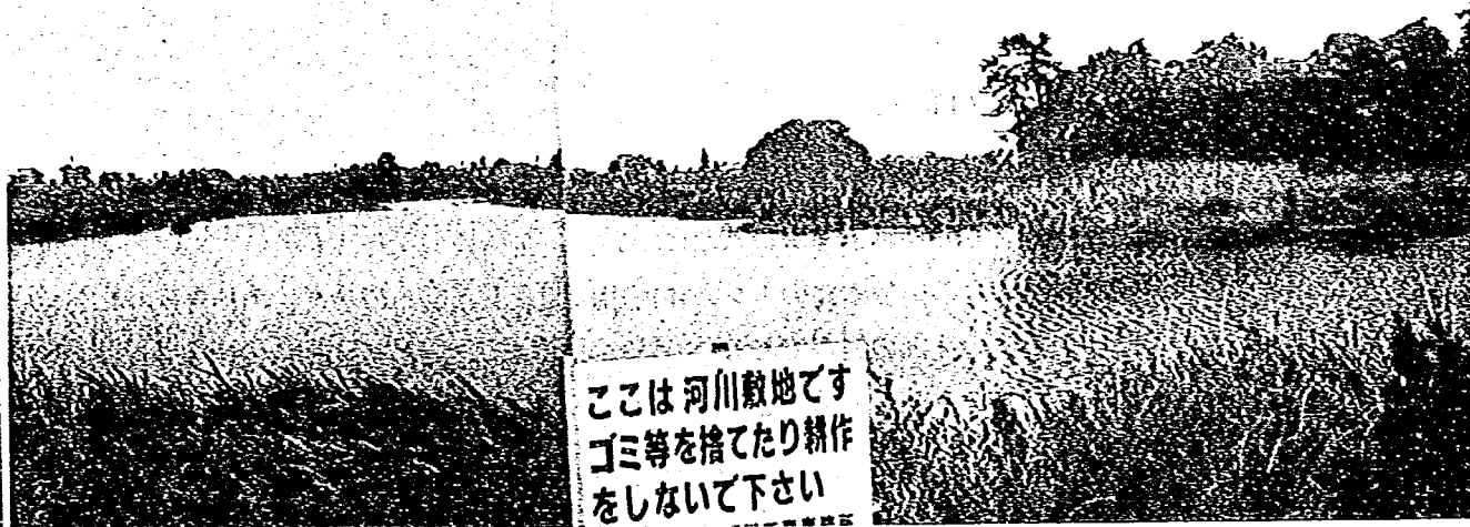
中央は3号放水路吐口予定地点であり、領内川は写真の左から右へ流下している。
