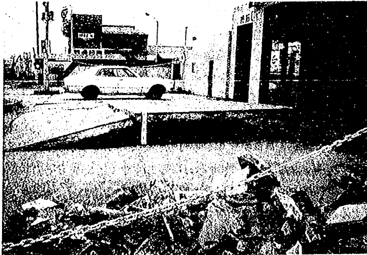
写真-1 地盤液状化によるオイルタンクの浮き上がり
