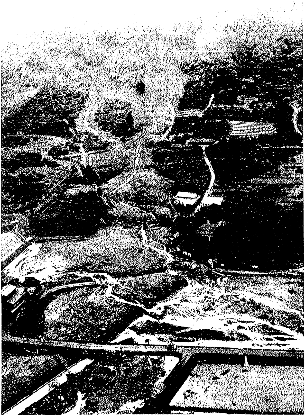
写真－3.3.7 原地区Eブロック被災全景
