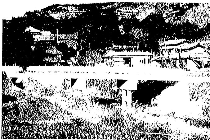
(a) 落橋前の瀬戸1号橋
