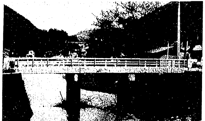
(a) 被災前の状況
