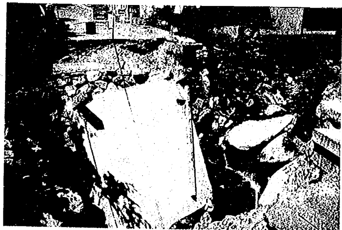
(b) 落下した上部工
