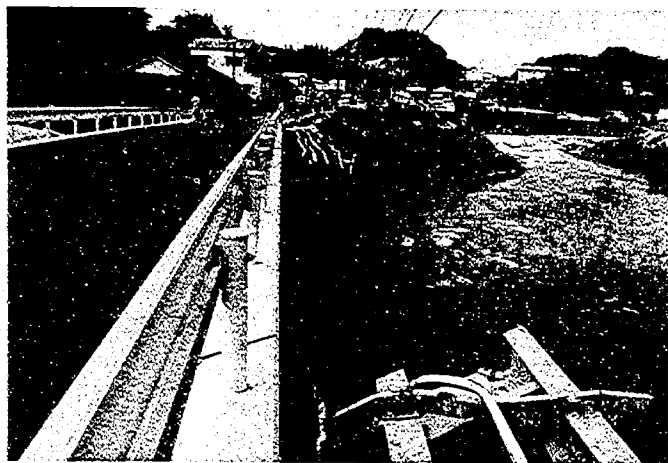
(b) 高欄部の復旧状況と拡幅歩道部の 落橋部分（平成2年8月24日）
