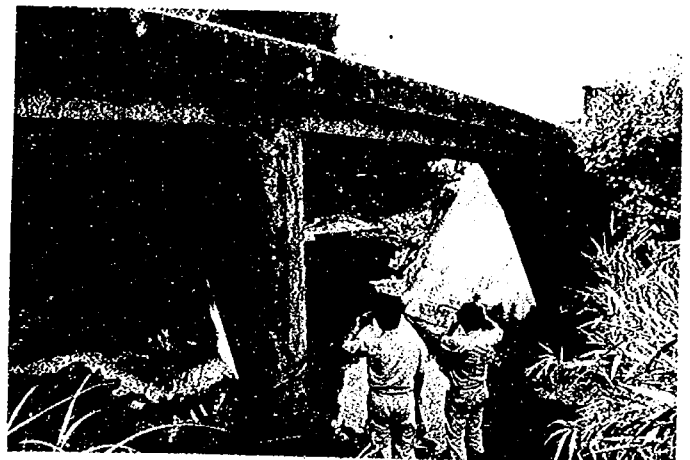
(a) 被災現場
