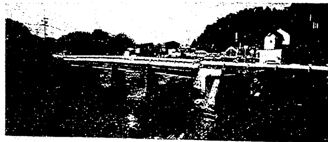
(c) J R 豊肥線鉄橋の被災現場（平成2年12月30日） 全く復旧されていない。
