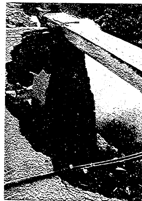
(b) 裏込め土砂が流出した左岸アバット取付部
