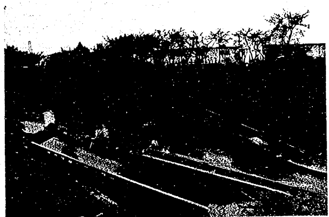
(b) 流失した上部工
