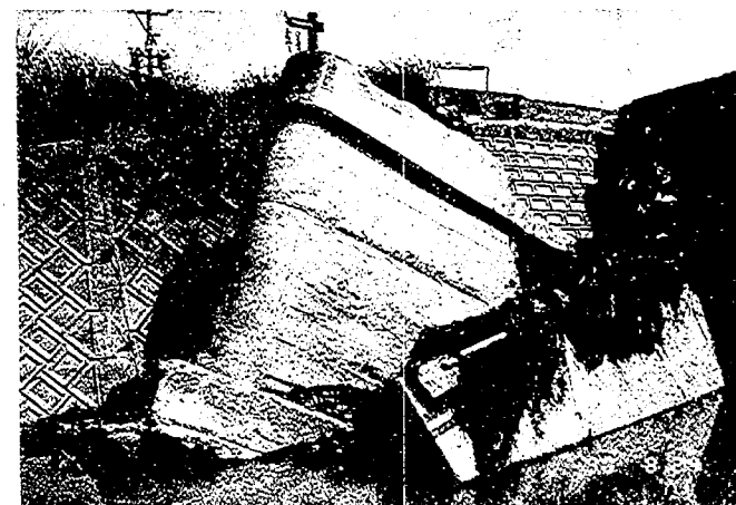
(c) 流失した橋脚および下流側上部工（橋脚の右手前）
