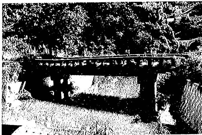
(a) 被災現場
