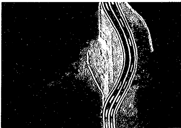
写真—19 伊豆スカイライン崩壊全景 (モニタービデオ垂直)
