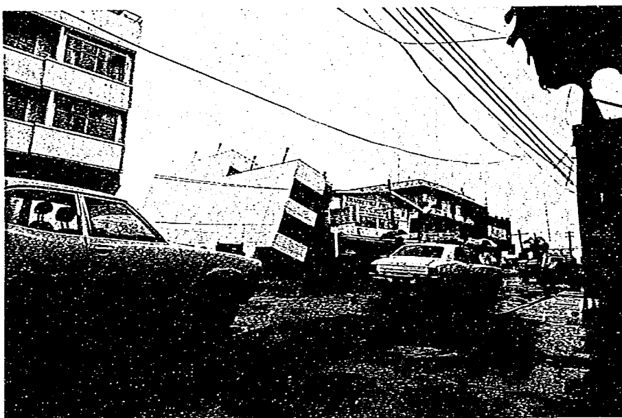
写真-3 ダグバン市の傾いたビル
