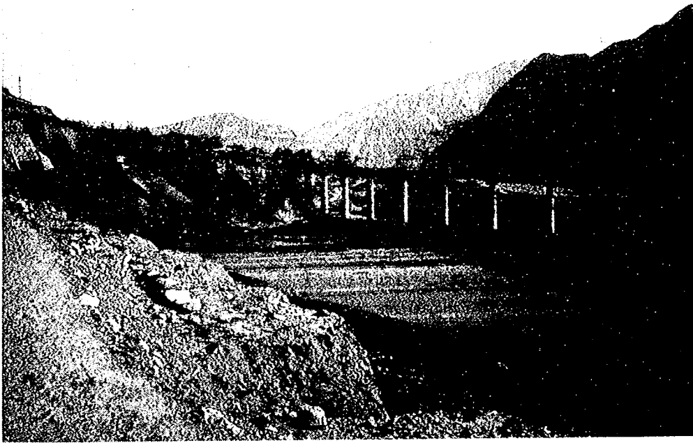
写真-6.2.1 路線変更による回避（橋梁）
