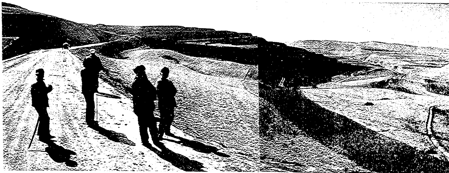
写真- 4.1.5 四方溝地すべり地内を通る道路より下方の状況
