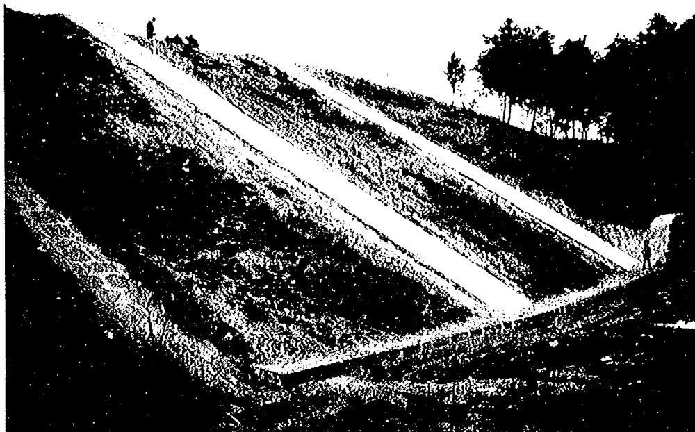
写真－6.2.16 切土斜面中には斜面排水溝（法面浸溝）が施工されている
