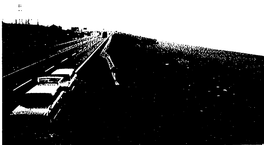
写真-191 新潟県の糸魚川海岸の災害 状況 (1974年4月27日)
