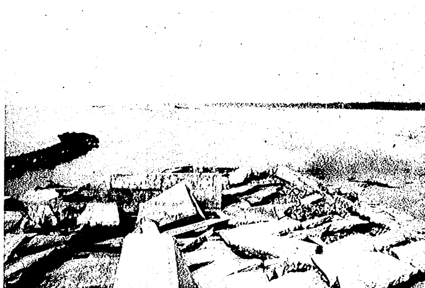
写真-93 静岡県の浜松海岸（五島地 先）の海岸堤防の被災状況 （1967年1月2日）
