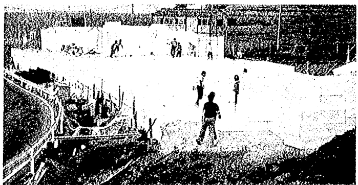
▲工事場所全景
