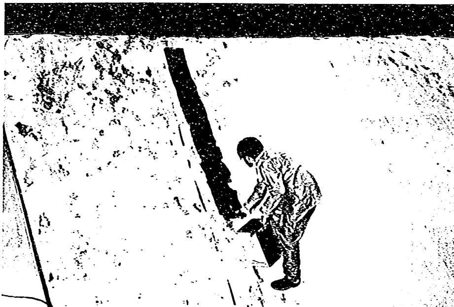
写真-11 継手部の処理状況
