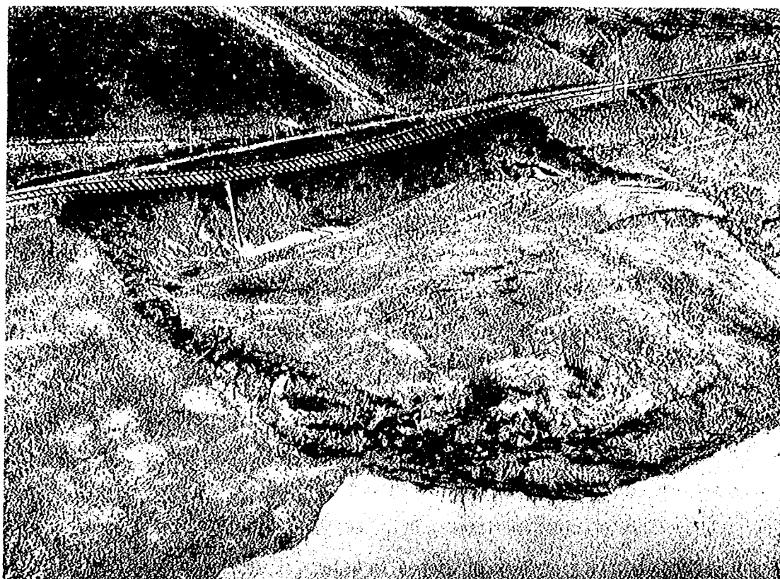
写真-4.4.1 グントルプ地すべり
