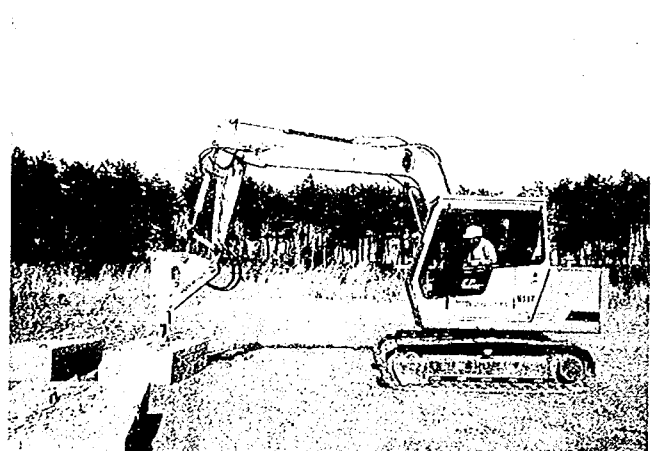
コンクリート版破碎状況
