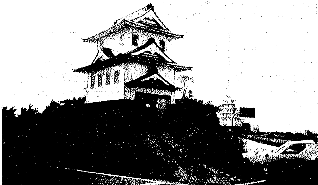
水防倉庫の全景
