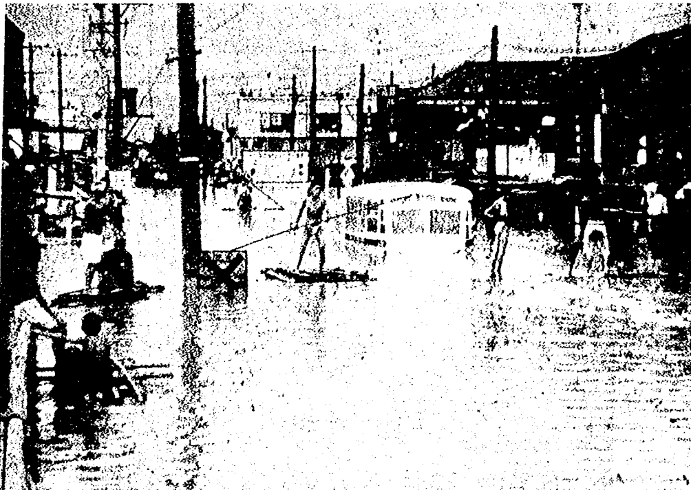
カスリーン台風による浸水（東京都葛飾区）
